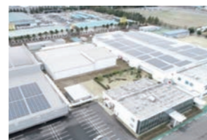
つくば工場 太陽光発電システム
